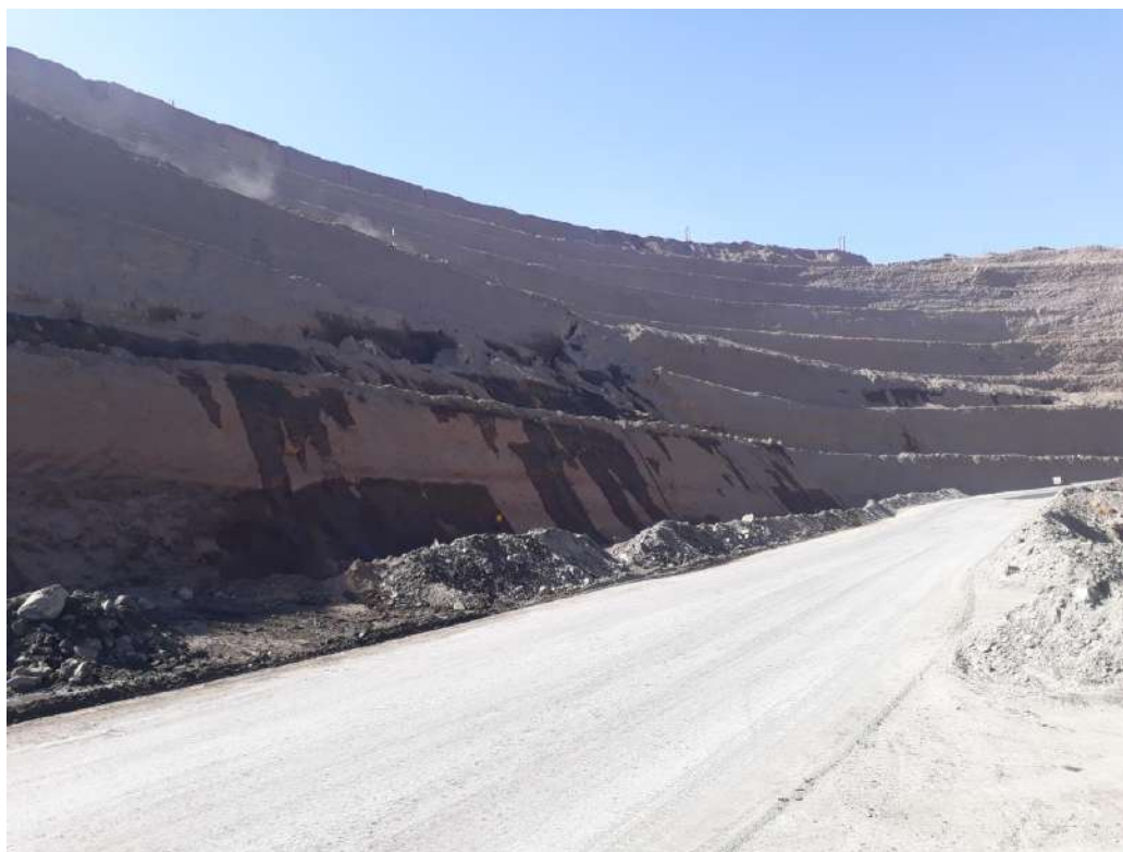
شکل (۱): نمایی از عملکرد میان لایه رسی در تراوش آب از دیواره جنوبی معدن شماره ۱ در محدوده برداشت‌های ژئوفیزیکی.
